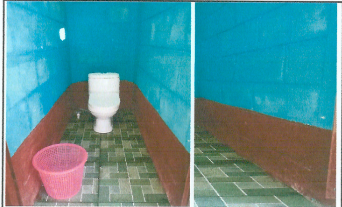
Foto 9 y 10: Reparación de azulejo en el área de los baños.
