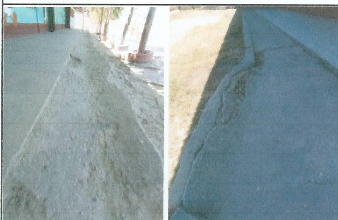
Foto 6 y 7: Mejoramiento de losa de concreto frente al centro educativo.
