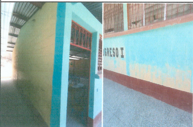
Foto 4 y 5 : Mejoramiento de pintura general del centro educativo.
